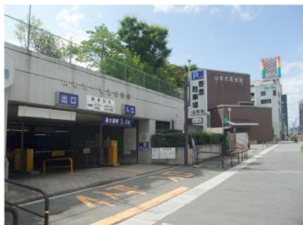
香澄駐車場 出入口
